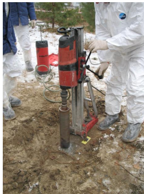
Рис. 21. Буровые работы на объекте ПВЛРО «300 м от объекта «Укрытие». Установка бурового станка «Hilti DD-250E»
