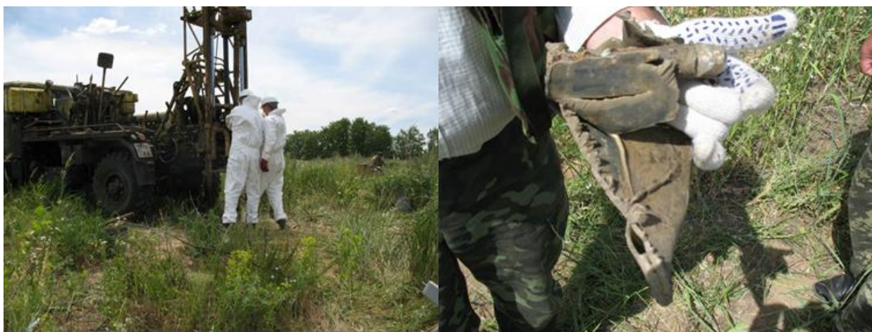
Рис. 24. Бурение глубоких скважин на ПЗРО «3-я очередь ЧАЭС». На фото слева – буровая установка УГБ-1ВС на точке бурения, на фото справа – образец металлоизделий, извлеченных из скважины при бурении
