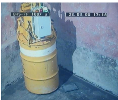
Рис. 13. ВХ ВАО и НСА-ДСО. Размещение упаковки РАО в отсек для хранения РАО
