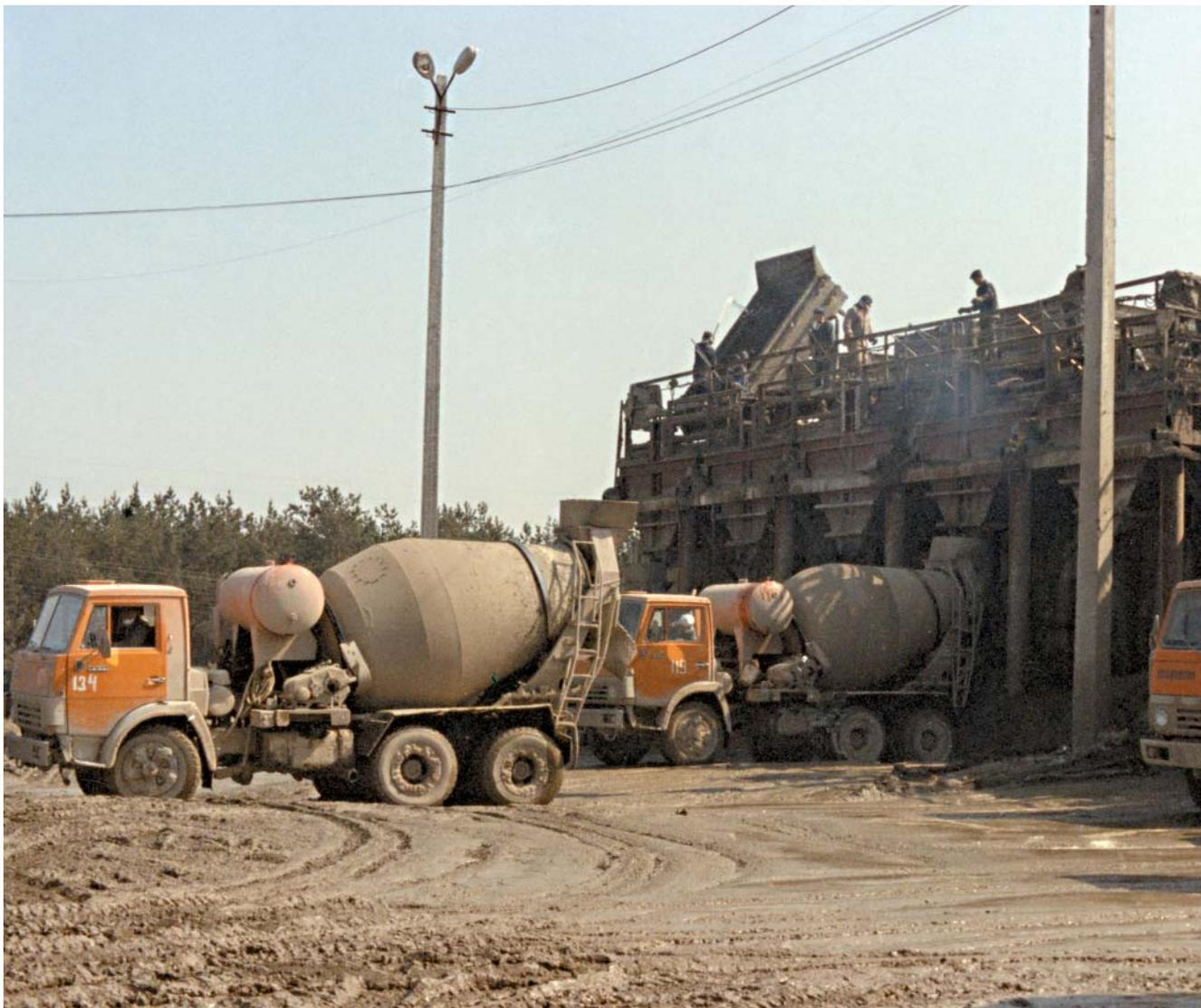
▲ Бетонные заводы были построены в непосредственной близости от строительной площадки "Укрытия". 1986 год
