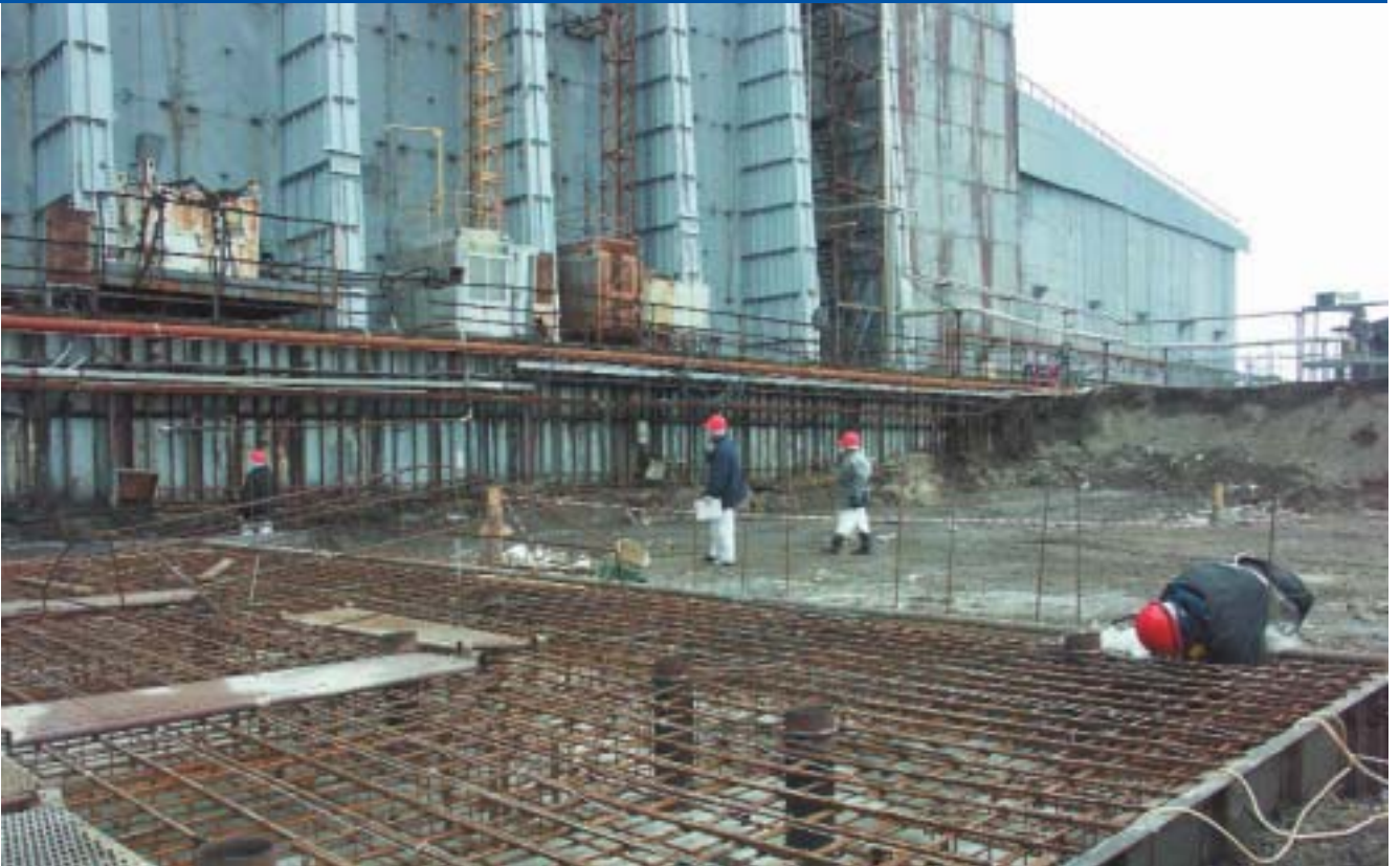
▲ Стабілізаційні роботи на "Укритті" у розпалі. Головне завдання – їх безпечне проведення
