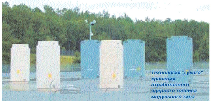
Технология "сухого" хранения отработанного ядерного топлива модульного типа
