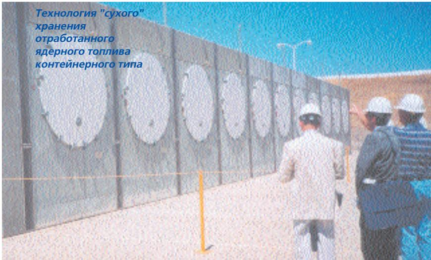
Технология "сухого" хранения отработанного ядерного топлива контейнерного типа
